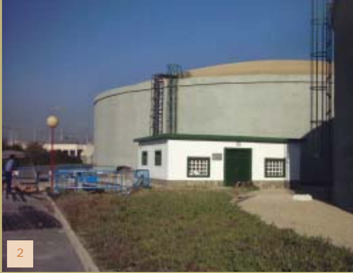
2- Exterior de los depósitos de agua potable de Carrús.
