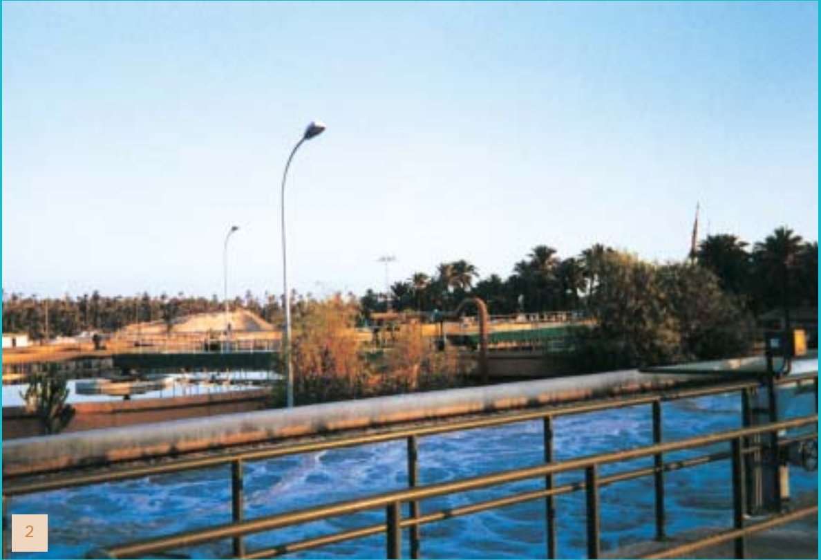
2- Una de las tres estaciones depuradoras de aguas residuales con las que cuenta Elche.
